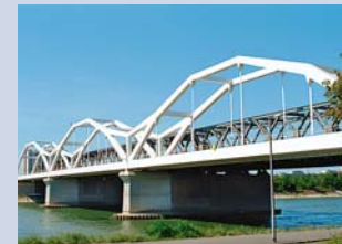
Eisenbahnbrücke über den Rhein Mannheim
