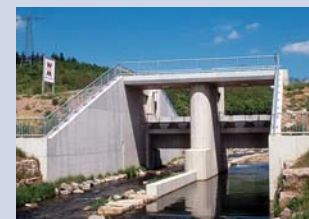
Hochwasserrückhaltebecken 53 Adelsheim/Kirnbau Planung: Ingenieurbüro Wald + Corbe, Hügelsheim
