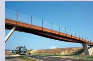
Fußgängerbrücke über die B 36 bei Karlsruhe Architektur: Gassmann Architekten, Karlsruhe
