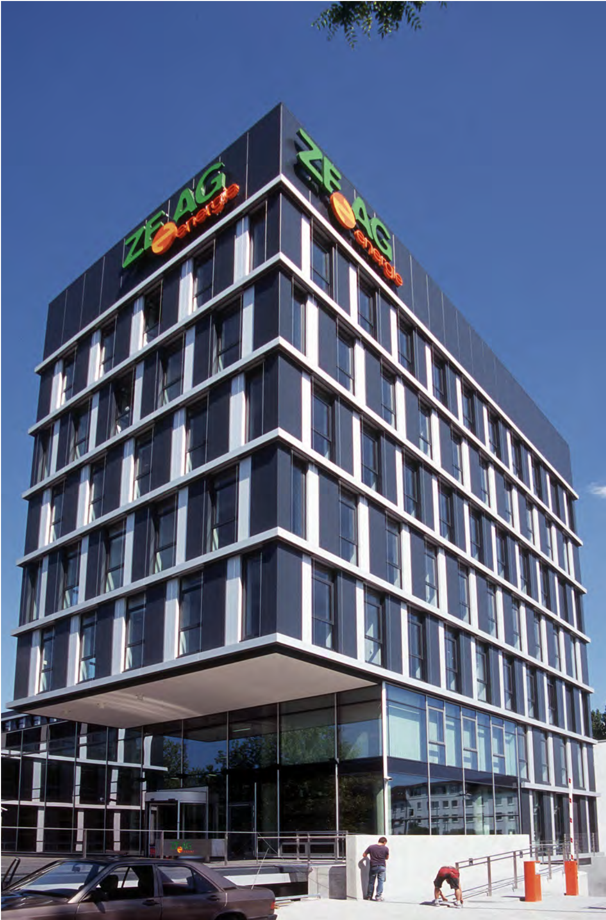
Hauptverwaltung der ZEAG Energie AG Heilbronn
